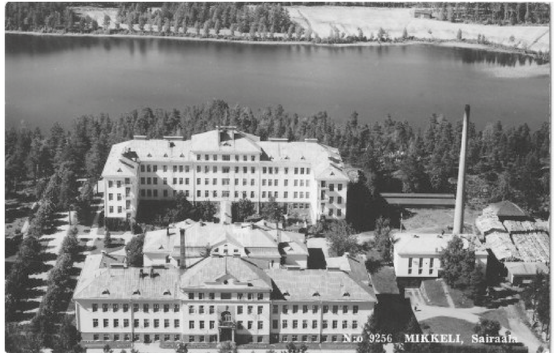
Kuva. Moision sairaalan rakennuksia kuvattuna lämpökeskuksen valmistuttua mutta ennen pesularakennuksen valmistumista, eli vuosien 1938 ja 1956 välillä. (Kuvaaja Veljekset Karhumäki Oy, Suur-Savon museon kokoelma)
