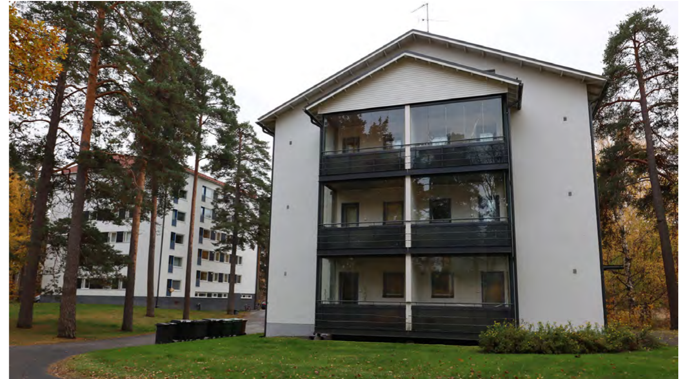
Kuva. Vasemmalla taustalla 1960-luvulla rakennettu kerrostalo, etualalla pistetalo. Rakennukseen on 2009 tehty julkisivukorjaus, jolloin myös parvekkeet on uusittu.
