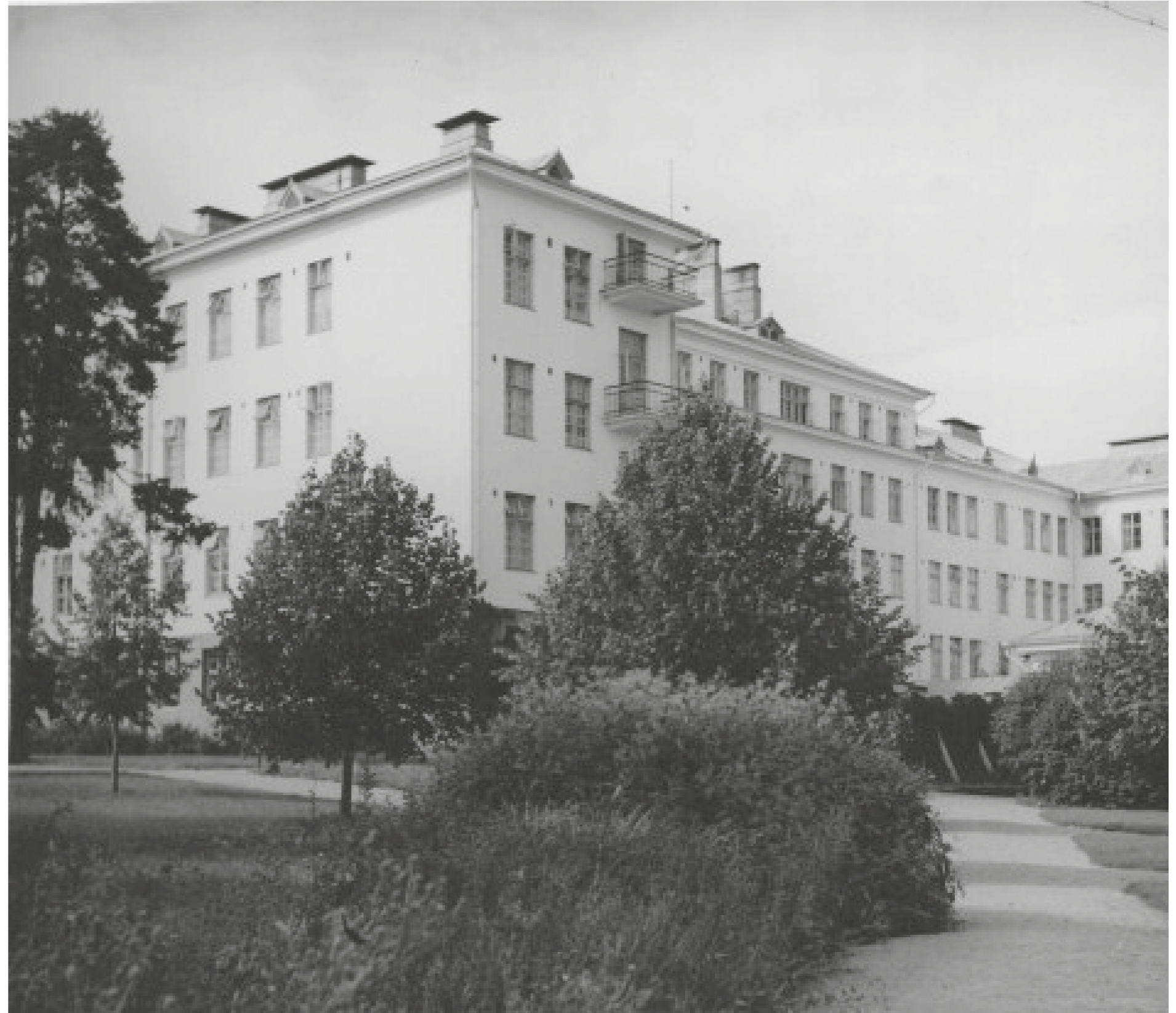
Kuva. Vanha kuva sairaalan päärakennuksen pihapiiristä. Puoliavoin puistomainen ja hoidettu viherympäristö on alueelle luonteenomainen. (Kuva. Mikkelin kaupunki)
