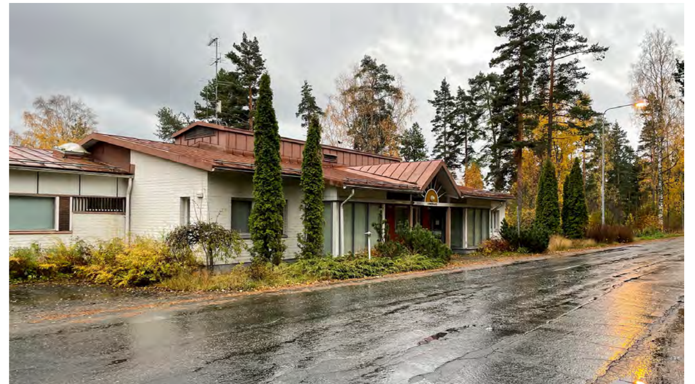
Kuva. Entinen osastolääkärien talo 1950-luvulta. Kuten valokuvista käy ilmi, Moisiantien asuinrakennukset eivät muodosta selkeää kokonaisuutta.
