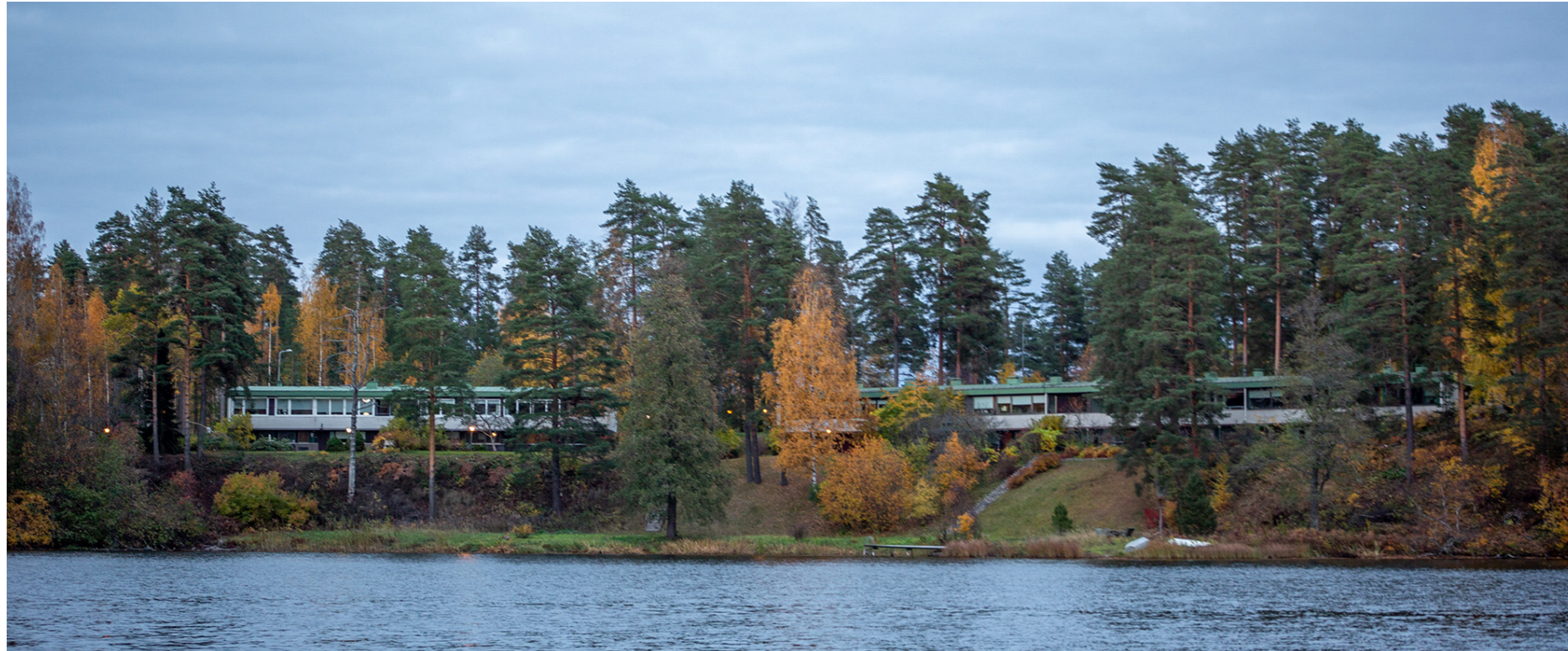
Kuva. 1960-luvulla rakennettujen rivitalojen pitkät rakennusmassat erottuvat rantamaisemassa. Moisionlammen rannoille suositellaan mieluummin rakennettavaksi erillispientaloja. Uuden rakentamisen ja lammen väliin suositellaan jätettävän vähintään 20 metriä leveä luonnonmukainen puustoinen suojavyöhyke.
